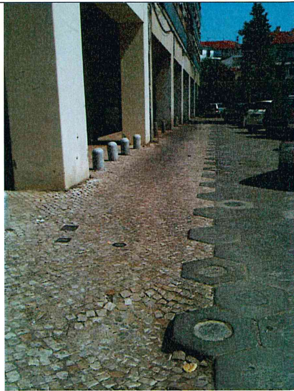
Único prédio com pavimento original, completado com calçada - Exemplo a replicar
