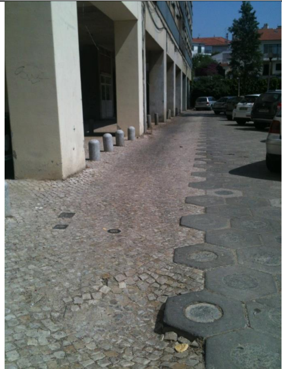
Único prédio com pavimento original, completado com calçada - Exemplo a replicar
