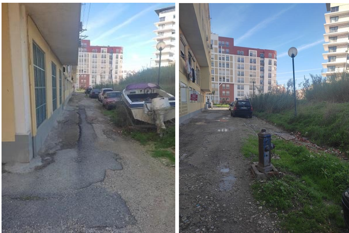
Fotografias 1 e 2 – Troço entre a Azinhaga das Galhadas e a rua António Albino Machado, sem passeio.
