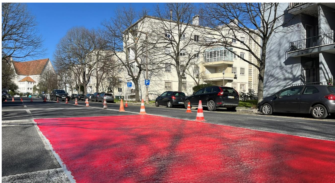
Figura 3 – Av. D. rodrigo da Cunha, durante a intervenção.
