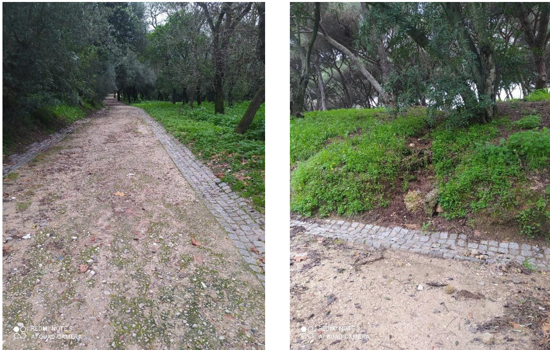
Figura 5 - Exemplos do estado de conservação da rede de caminhos
