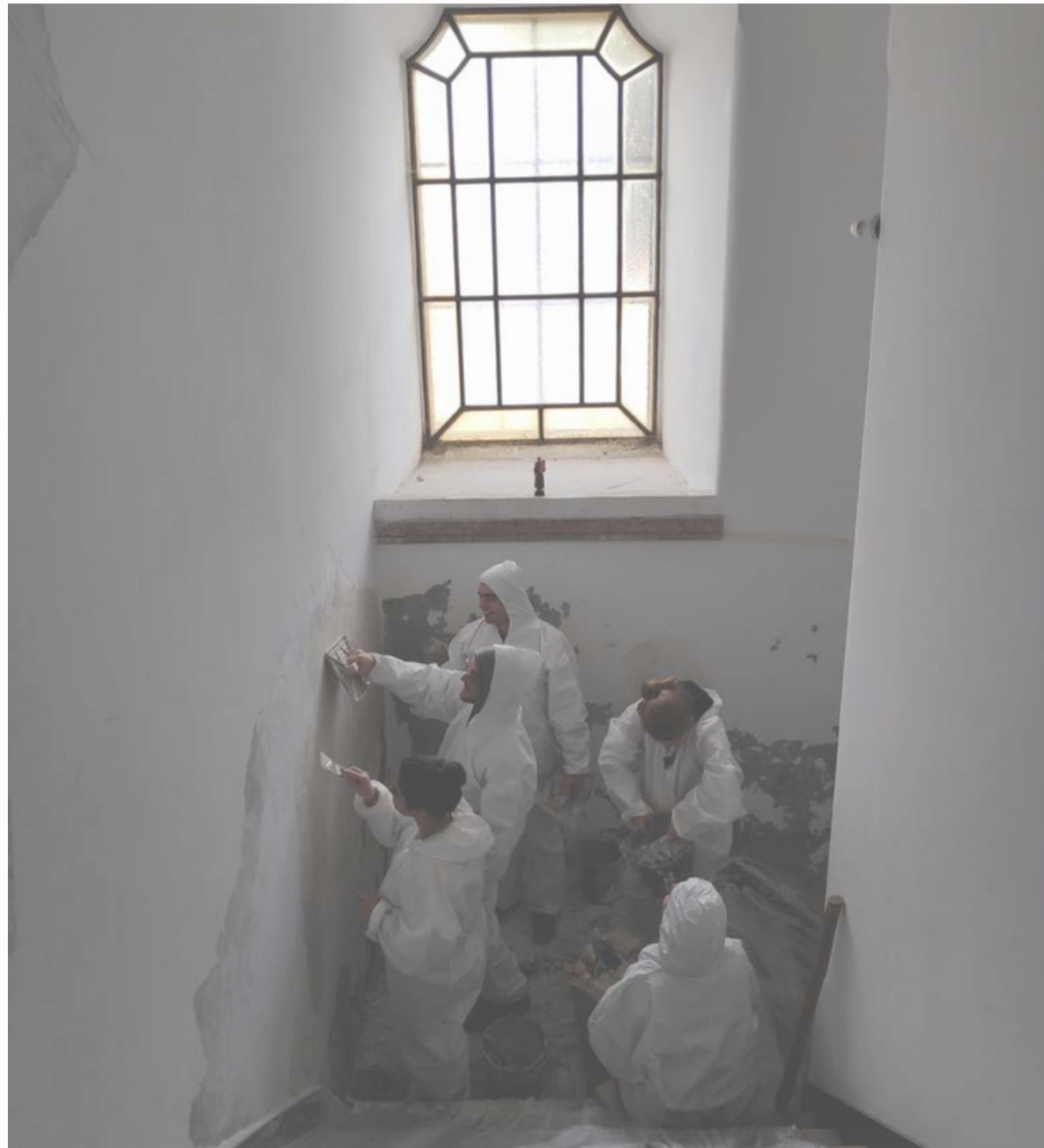
01 Preparação das paredes
