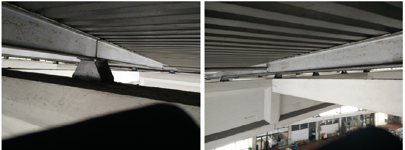
Figura 14 – Madres metálicas IPE-160 vistas ao nível da cobertura.
