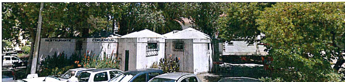
Foto 2 – Equipamento a substituir
